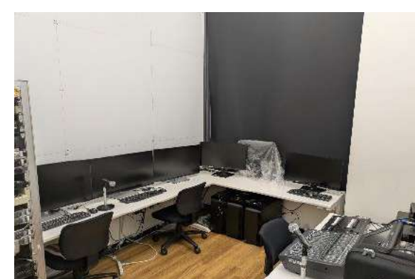
④オペレーションルーム
